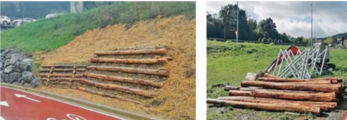
74. irudia. Lehendik zegoen harri-lubeta, trantsizioko egur-horma bakuna eta Loricata egur-horma. Iturria: R. Etxebarria. Arrigorriagako bidegorria. BFA
