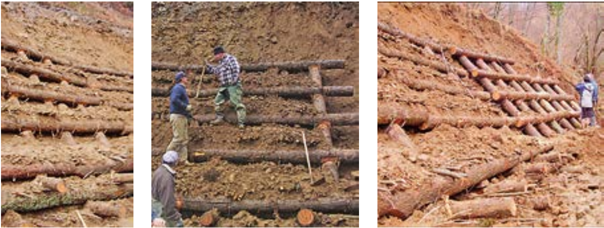
66. irudia. Egur-hormak eta egur-hesiak egiten, 2008ko otsailean. Iturria: P. Sangalli – SCIA SL
