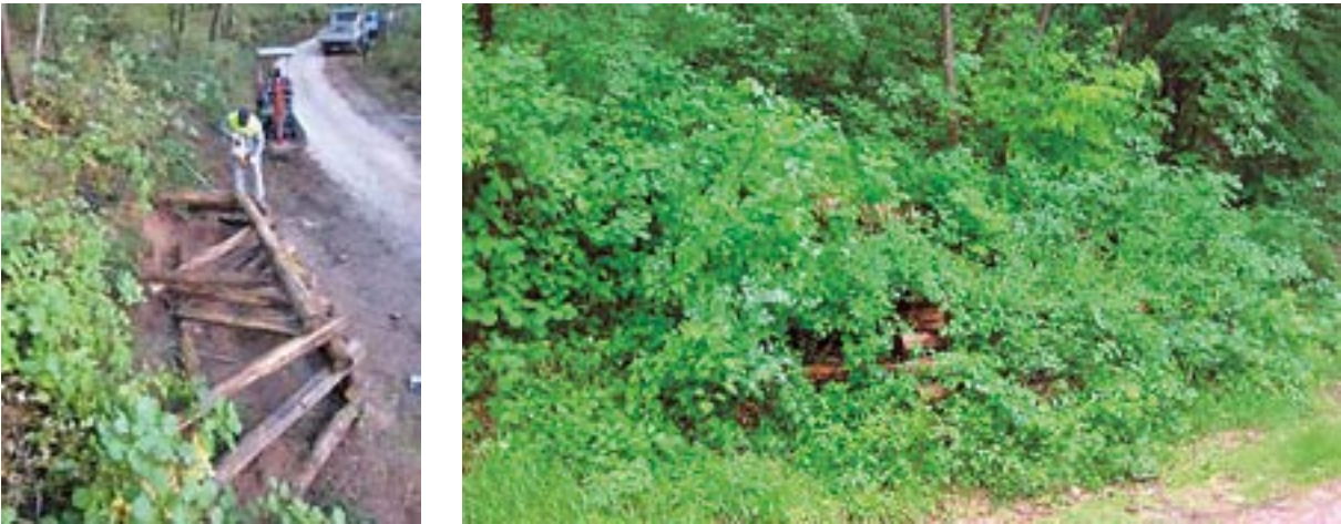
135. irudia. Latina egur-horma biziaren adibidea: egitura egiten, eta egin eta hilabete batzuetara. Iturria: P. Cornolini
