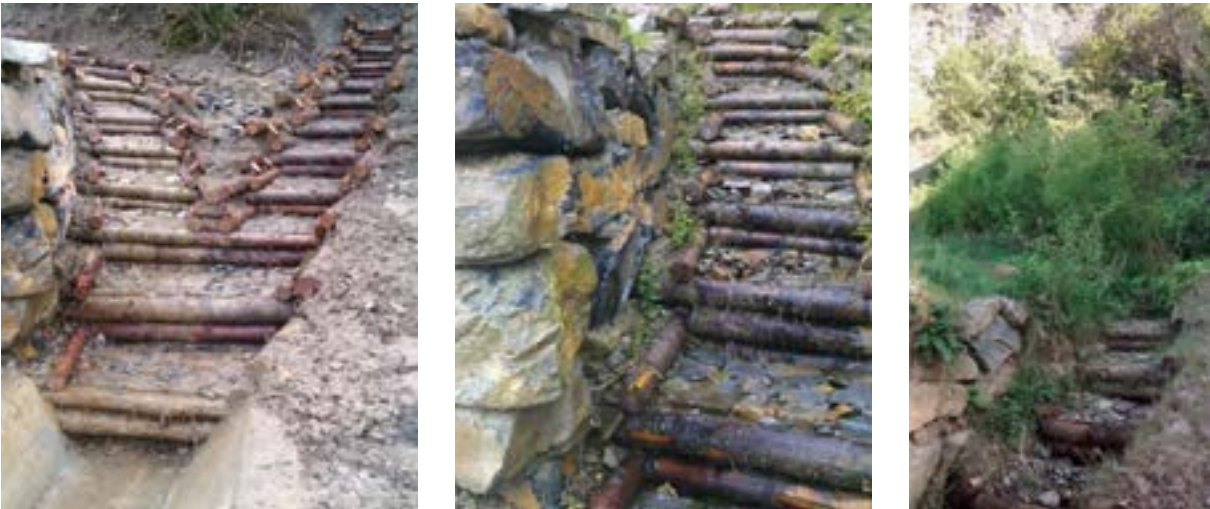
179. irudia. Harrizko eta zurezko zorrotena. Areka jauzien bidez moldatuta eta denboraren poderioz izandako bilakaera. Iturria: P. Sangalli – SCIA SL
