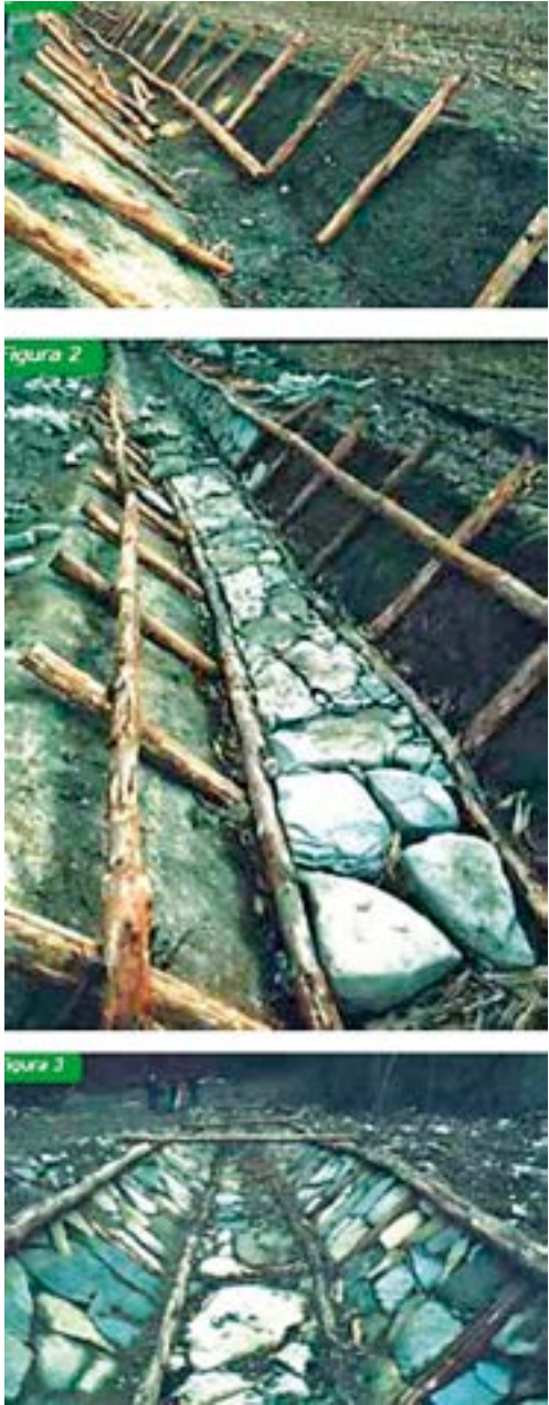
197. irudia. Harrizko hegalkak dituen harrizko eta zurezko arekaren eraikuntza-prozesuko faseak. Iturria: S. Sangalli – SCIA SL
