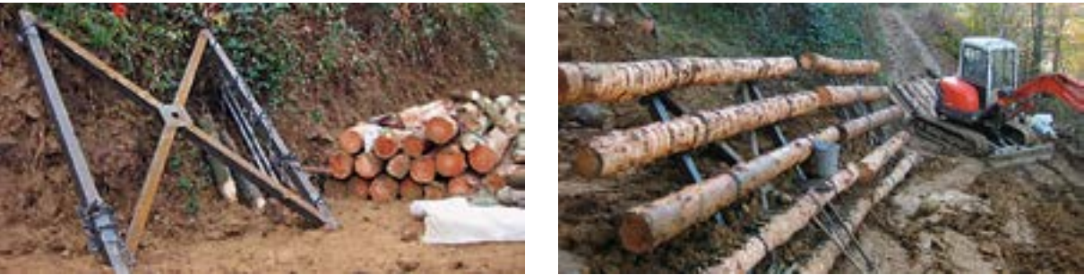
46. irudia. Loricata egitura, goiko Loricatak eraikitze-prozesuan eta goiko Loricatak amaituta. 45. irudiko 4 zenbakikoa da. Iturria: P. Sangalli - SCIA SL
