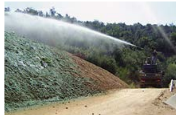
89. irudia. Hidromanta aplikatzen eta aplikatu ondoren. Iturria: A. Sorolla
