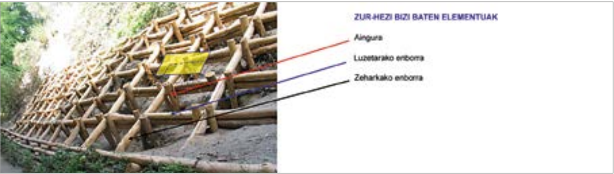
175. irudia. Egur-hesi bizen elementuak. Iturria: Gino Menegazzi (egokitua)
