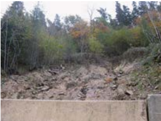
43. irudia. Lur-irristatzearen egoera eta areka hautsita. Iturria: P. Sangalli - SCIA SL - IKERLUR SL
