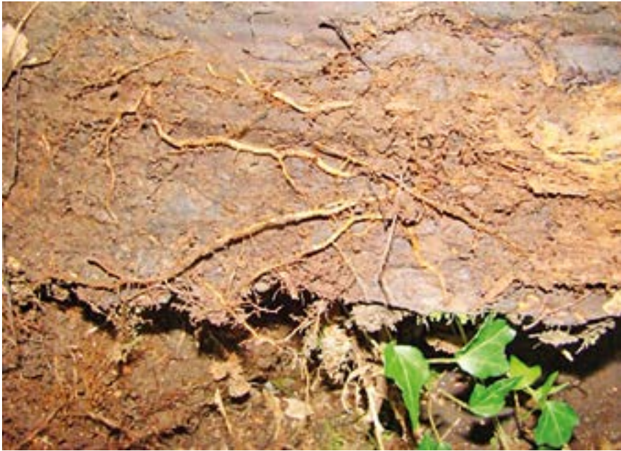
30. irudia. Egur-horma bateko enborrak oso deskonposizio-fase aurreratuan (Artia ubidea, Irun). Lehen enborrek zuten lekua orain landareen sustraiek hartzen dute eta haien mantenugaiak xurgatzen dituzte. Iturria: G. Tardío
