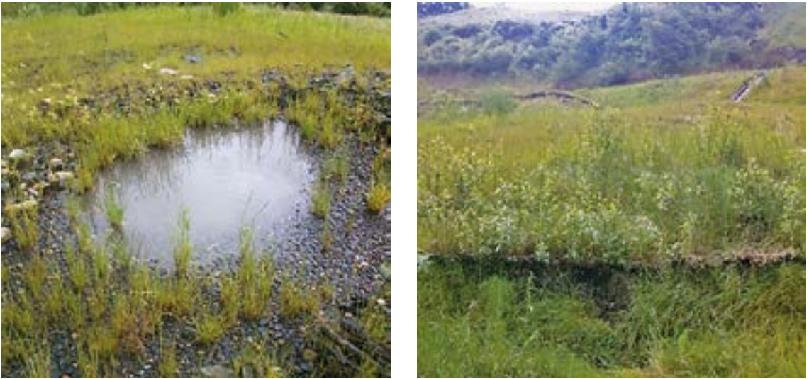
61. irudia. Ura biltzeko putzuen funtzionamendua eta adar-mailen muskiltze-egoera, lanak gauzatu eta urtebetera. Iturria: P. Sangalli – SCIA SL
