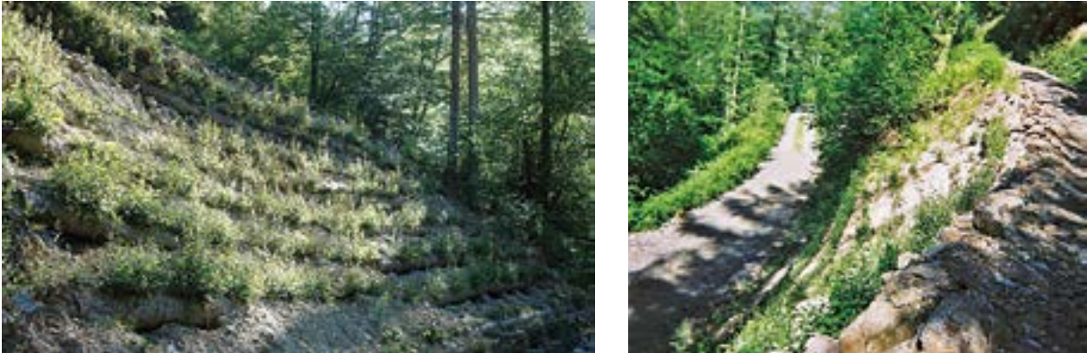
66. irudia. Egur-hormak eta egur-hesiak egiten, 2008ko otsailean. Iturria: P. Sangalli – SCIA SL
