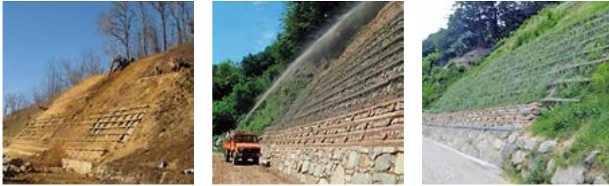
23. irudia. Errepideko zenbait ezponda egur-hormekin eta hesi biziak (Biella, Italia). Iturria: Alpivert
