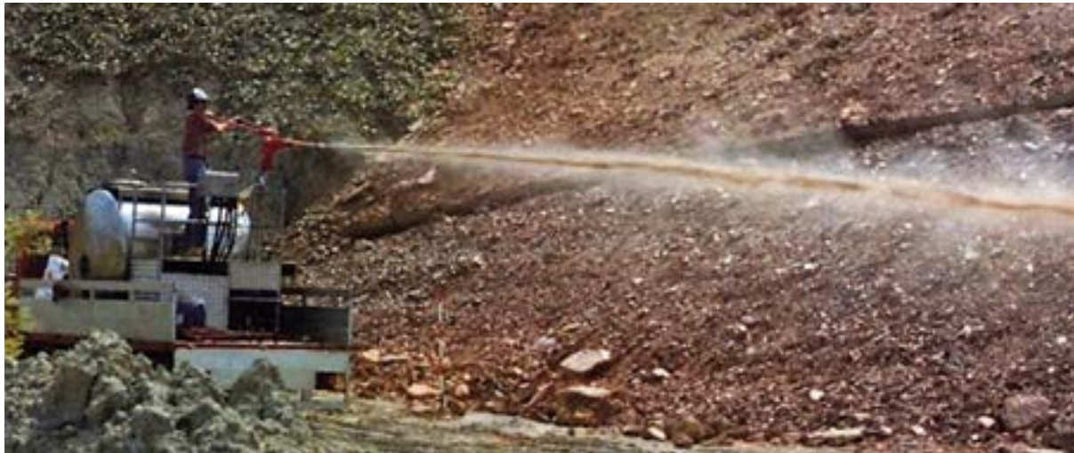
87. irudia. Ereiteko makina hidraulikoa, hidromanta proiektatzen. Iturria: P. Sangalli – SCIA SL
