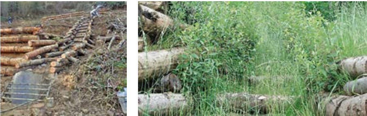
49. irudia. Harrizko eta zurezko kanaleta, eta lehendik zegoen hustubidearekin lotzea. Iturria: P. Sangalli – SCIA SL
