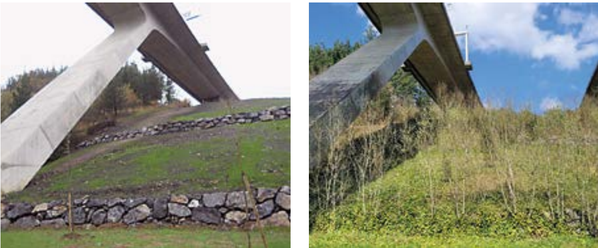
204. irudia. Harri-lubeta landatu bat: obra amaitu berritako xehetasuna eta garapenaren hasiera. Iturria: P. Sangalli – SCIA SL
