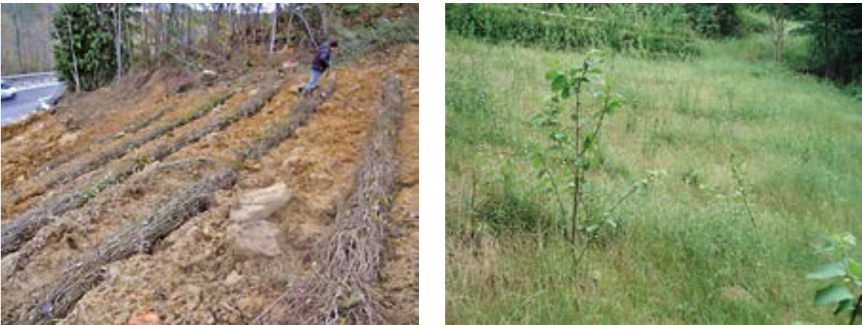
51. irudia. Adar-sortak estali aurretik eta adar-sortak muskilduta. 45. irudiko 6 zenbakikoa da. Iturria: P. Sangalli – SCIA SL
