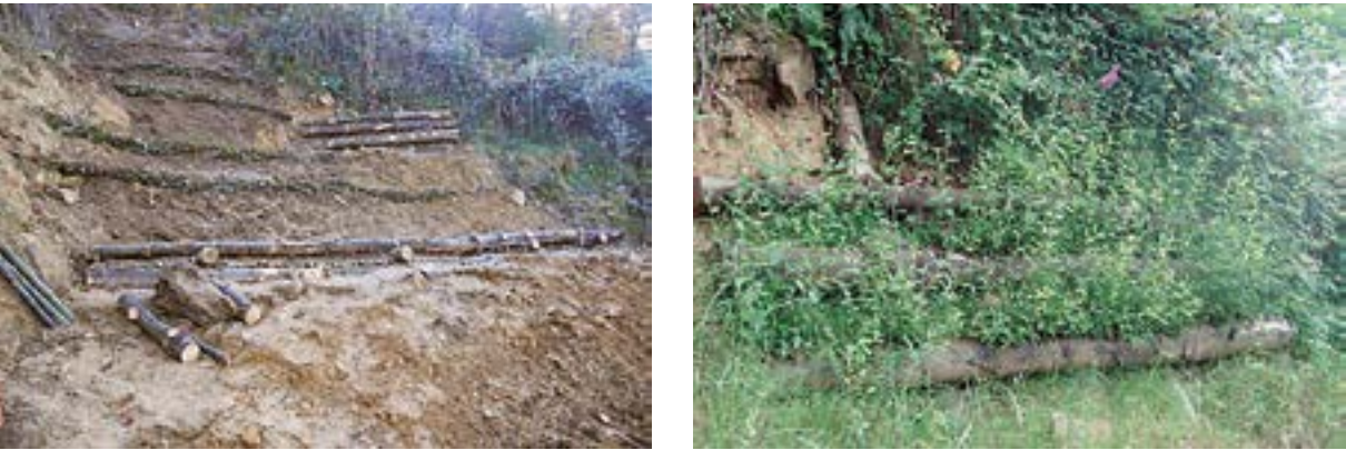
48. irudia. Egur-hesia eta adar-sortak. Iturria: P. Sangalli - SCIA SL. 45. irudiko 5 zenbakikoa da
