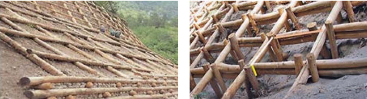
168. irudia. Ezkerrean egur-hesi normala, eta eskuinean Vesubio erako egur-hesia, zeharkakoetan zuresiek in. Iturria: P. Sangalli – SCIA SL eta G. Menegazzi
