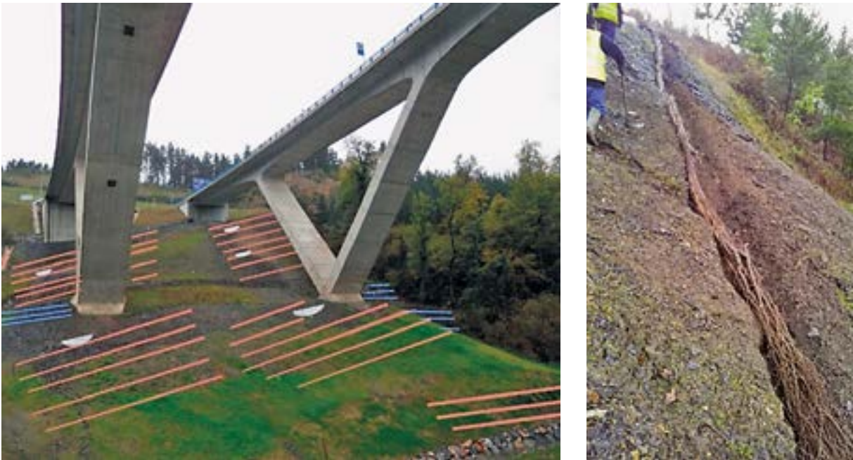
57. irudia. Adar-sortak jartzeko lanaren eskema, eta adarrentzako/adar-sortentzako zeharkako mailak egiten. Iturria: P. Sangalli – SCIA SL
