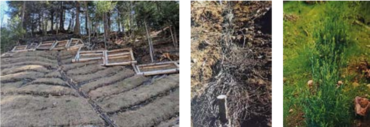
Irudiak 105. Drainatzeko adar-sortak, babesteko mantarekin. 106. irudia. Drainatzeko adar-sorta baten xehetasuna eta geroko itxura, lanak gauzatu eta 6 hilabetera. Iturria: F. Florineth
