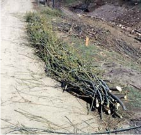
98. irudia. Adar-sortaren xehetasuna. Iturria: F. Florineth eta P. Sangalli – SCIA SL
