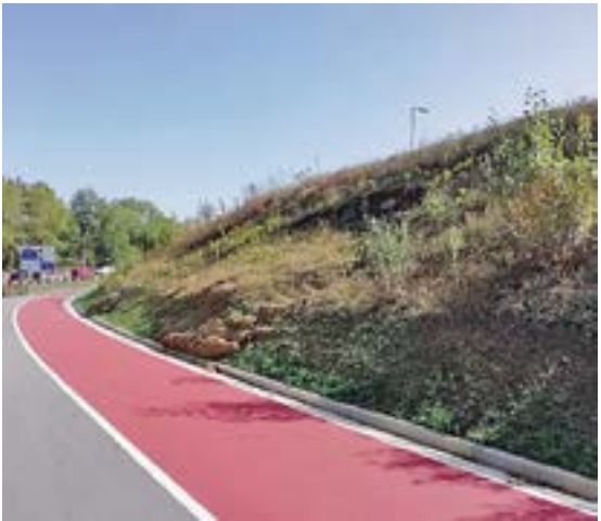
70. irudia. Irristatzeen egoera eta lurzorua sakonean ainguratzeko landare-elementurik eza. Iturria: R. Etxebarria, Arrigorriagako bidegorria. BFA
