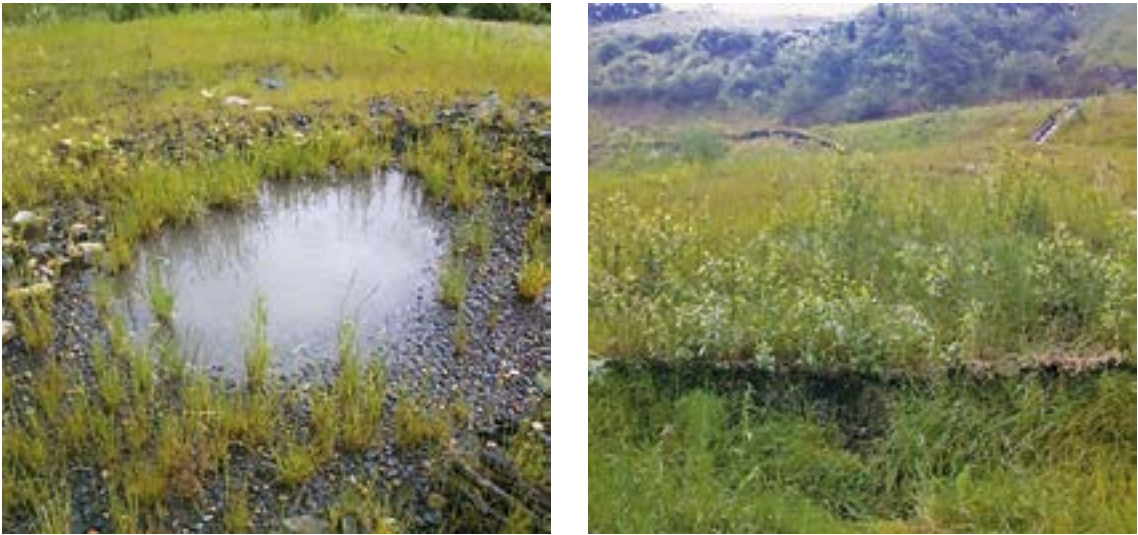
Imagen 61. Funcionamiento de los pozos de recogida de agua y brotación de los lechos de ramaje un año tras la ejecución de las obras . Fuente: P. Sangalli - SCIA S.L.
