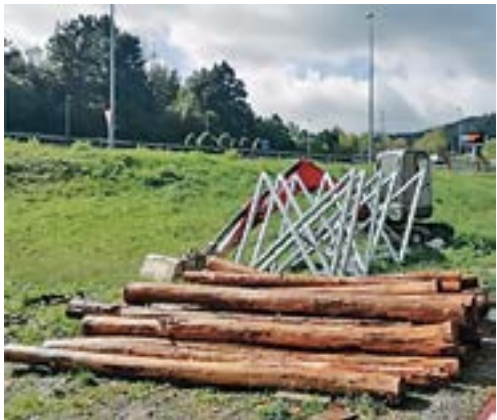
Imagen 75. Materiales y maquinaria empleada durante la obra. Fuente: REG
