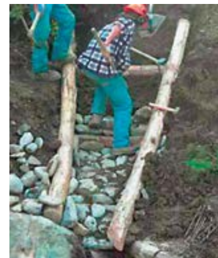
Imagen 183. Bajante en piedra y madera con cajero simple. Fuente: F. Florineth
