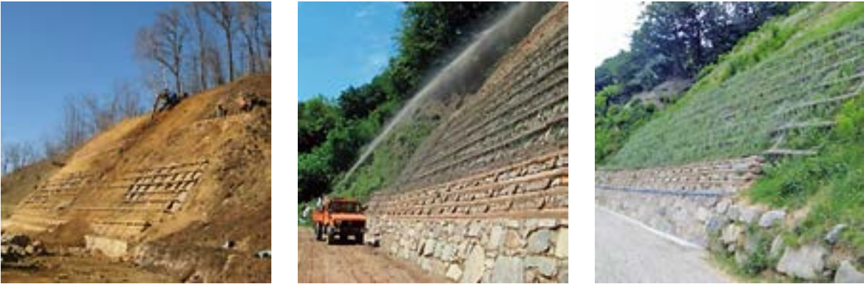
Imagen 23. Ejemplos de taludes en carreteras con entramados y enrejados vivos de madera (Biella-Italia). Fuente: Alpivert
