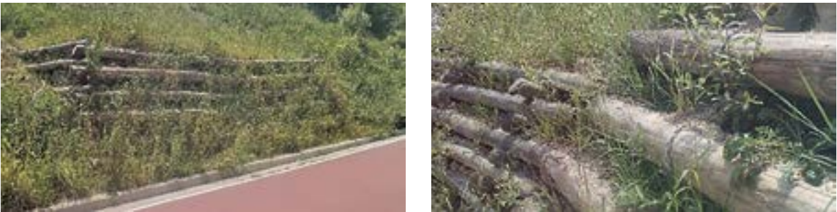
Imagen 73. Loricatas tras seis meses desde su instalación. Fuente: R. Etxebarria. Bidegorri Arrigorriaga. DFB
