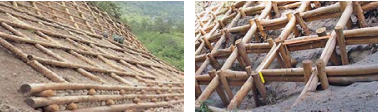
Imagen 168. Enrejado normal y enrejado tipo “Vesubio” con empalizada en los transversales. Fuente: P. Sangalli - SCIA S.L. y G. Menegazzi
