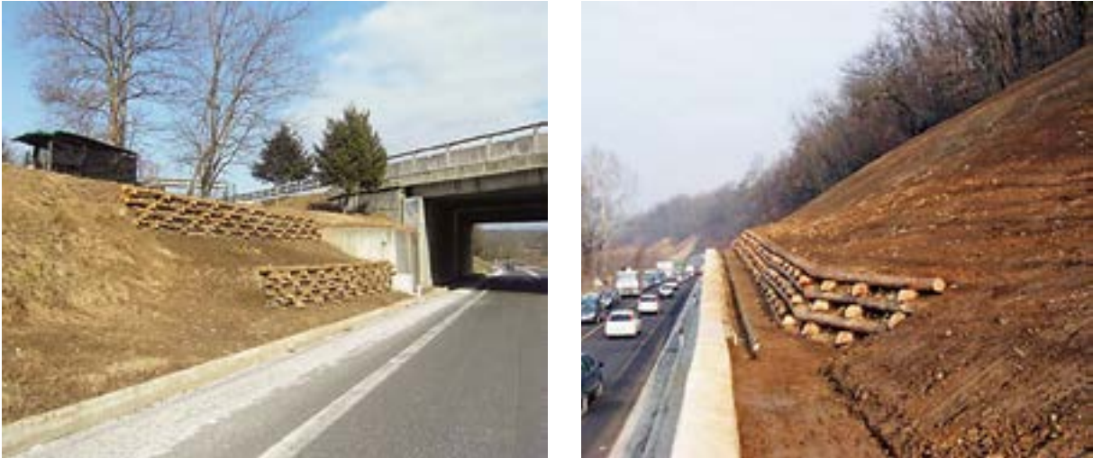
Imagen 24. Ejemplo del empleo de madera en las técnicas hasta el desarrollo de la vegetación
