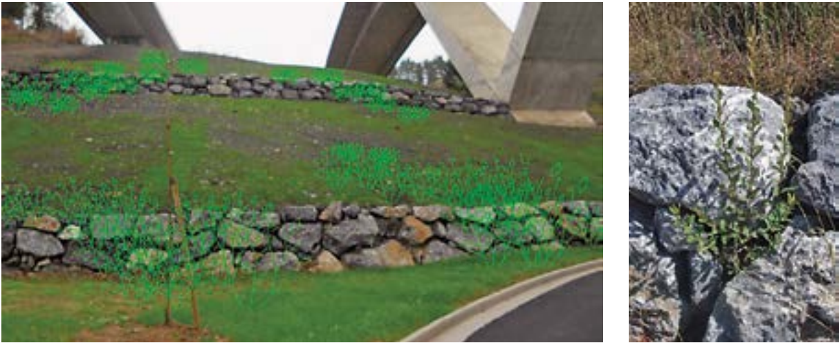
Imagen 56. Esquema de estaquillado en escollera. Fuente: P. Sangalli - SCIA S.L.
