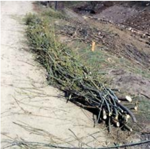
Imagen 98. Detalle de fajina. Fuente: F. Florineth y P. Sangalli - SCIA S.L.
