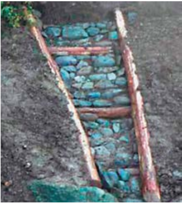
Imagen 181. Bajante en piedra y madera con cajero simple
