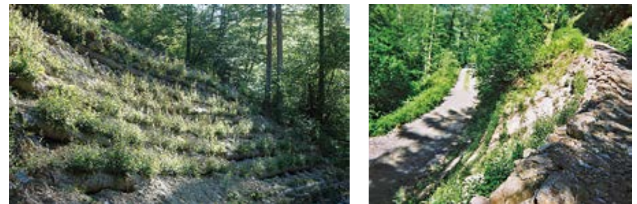
Imagen 66. Entramados y enrejados en ejecución febrero 2008. Fuente: P. Sangalli - SCIA S.L.
