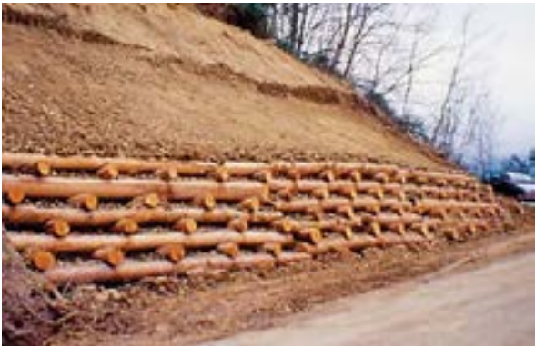
Imagen 130. Entramado de madera doble vivo un año después de su construcción. Fuente: P. Cornolini
