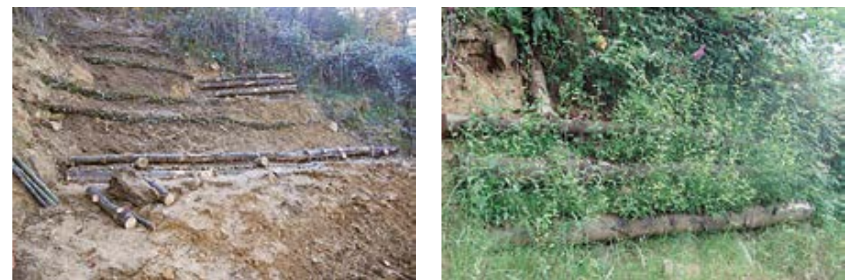
Imagen 48. Enrejado y fajinas. Fuente: P. Sangalli - SCIA S.L. En la imagen 45 indicado por el número 5.
