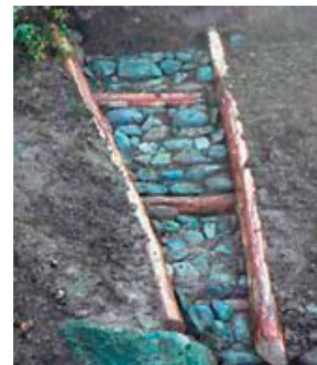
Imagen 183. Bajante en piedra y madera con cajero simple. Fuente: F. Florineth
