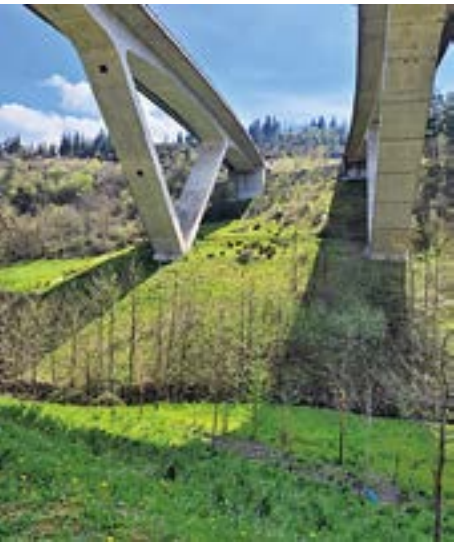
Imagen 61. Funcionamiento de los pozos de recogida de agua y brotación de los lechos de ramaje un año tras la ejecución de las obras . Fuente: P. Sangalli - SCIA S.L.
