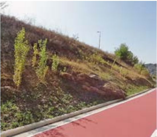
Imagen 70. Situación de deslizamientos y la ausencia de elementos vegetales que anclen los suelos en profundidad. Fuente: R. Etxebarria. Bidegorri Arrigorriaga. DFB
