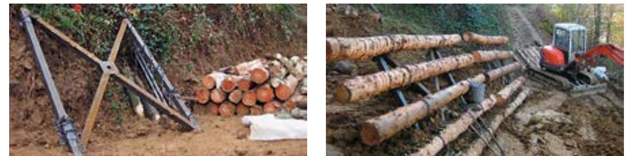
Imagen 46. Estructura loricata, loricatas superiores en ejecución y loricatas superiores terminadas. En la imagen 45 se corresponde con el número 4. Fuente: P. Sangalli - SCIA S.L.
