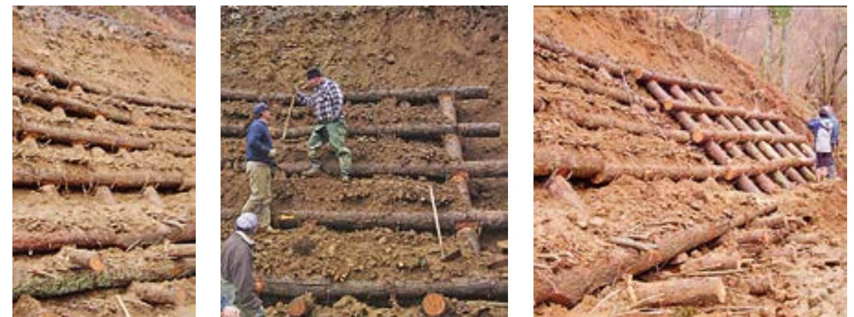
Imagen 66. Entramados y enrejados en ejecución febrero 2008. Fuente: P. Sangalli - SCIA S.L.
