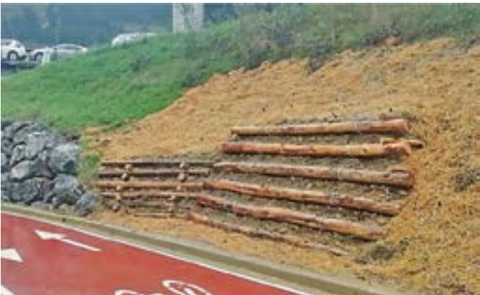
Imagen 74. Escollera existente, entramado de madera simple de transición y entramado loricata. Fuente: R. Etxebarria. Bidegorri Arrigorriaga. DFB
