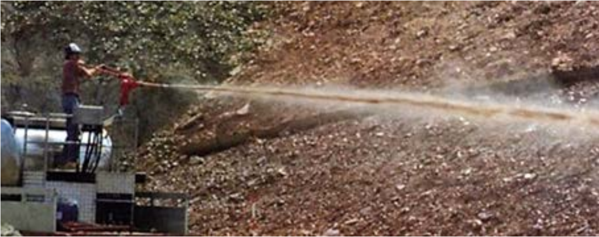
Imagen 87. Hidrosembradora proyectando una hidromanta. Fuente: P. Sangalli-SCIA S.L.
