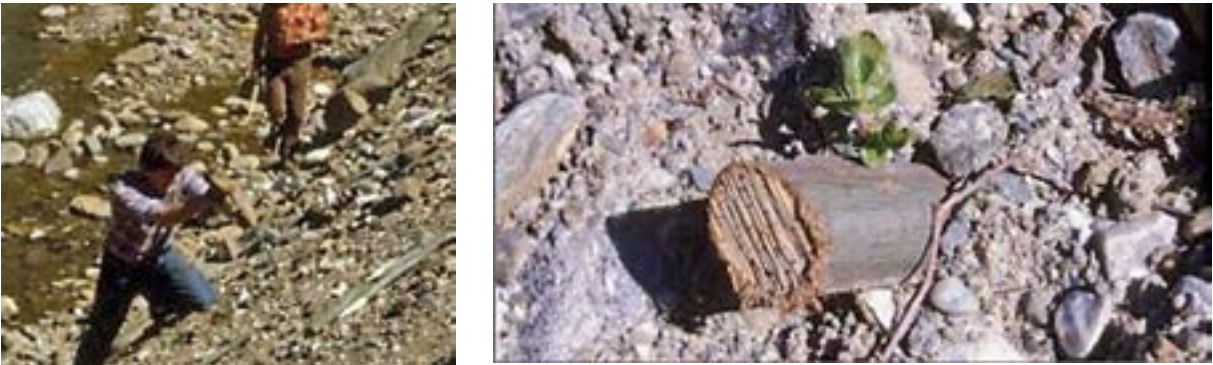
Imagen 93. Detalle de estaquillado. Fuente: Florineth y P. Sangalli - SCIA S.L.
