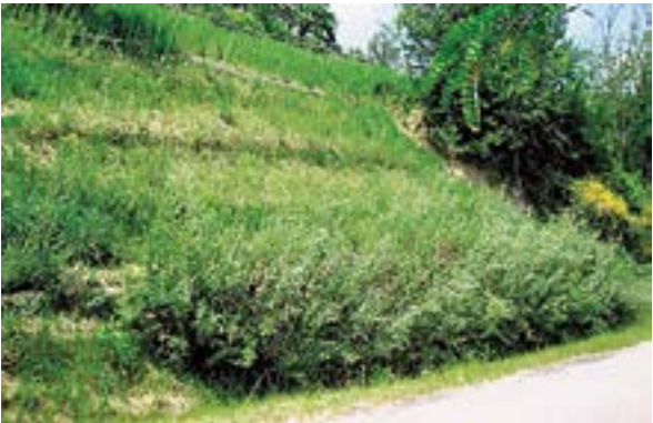
Imagen 130. Entramado de madera doble vivo un año después de su construcción. Fuente: P. Cornolini
