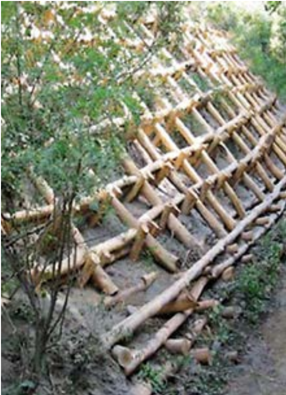
Imagen 171. Variante enrejado vivo “Vesubio”. Fuente: G. Menegazzi con dibujo de S. Sangalli - SCIA S.L.
