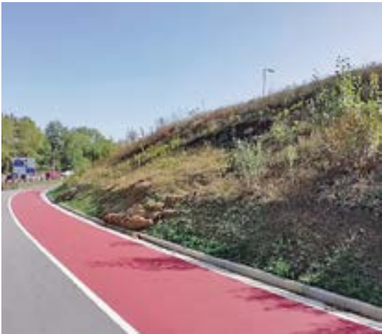
Imagen 70. Situación de deslizamientos y la ausencia de elementos vegetales que anclen los suelos en profundidad. Fuente: R. Etxebarria. Bidegorri Arrigorriaga. DFB
