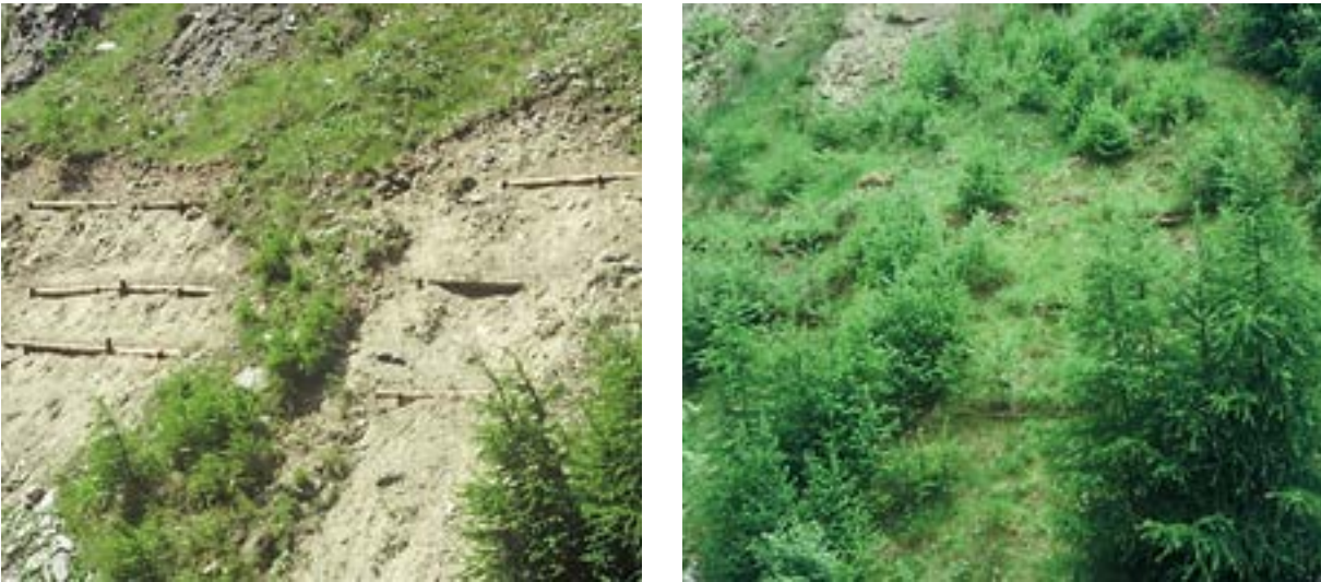
Imagen 117. Empalizadas vivas en ladera, apenas construidas y tras cuatro años. Valle Venosta, Italia. Fuente: F. Florineth
