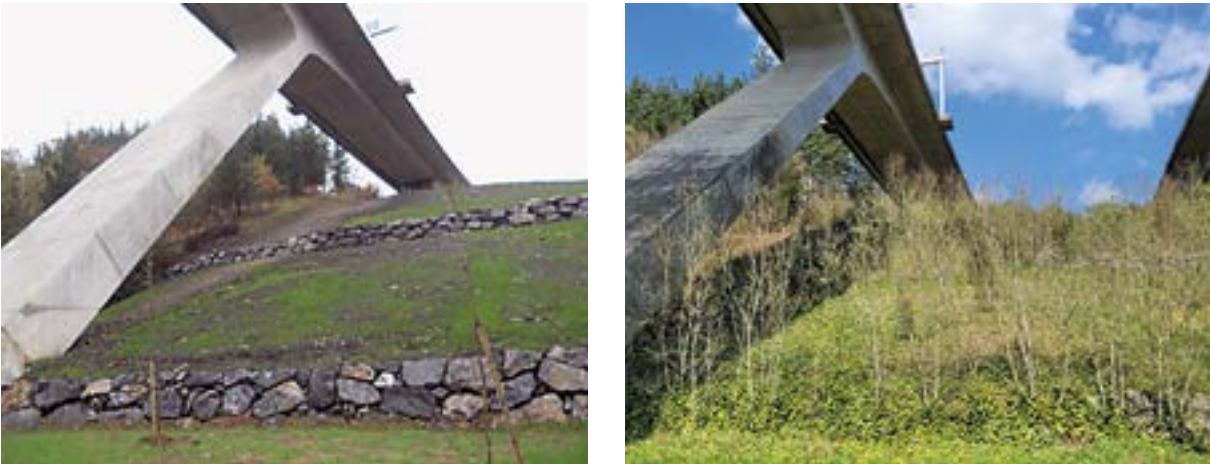
Imagen 204. Detalle de la finalización de la ejecución de las obras e inicio del desarrollo de escollera vegetalizada Fuente: P. Sangalli - SCIA S.L.
