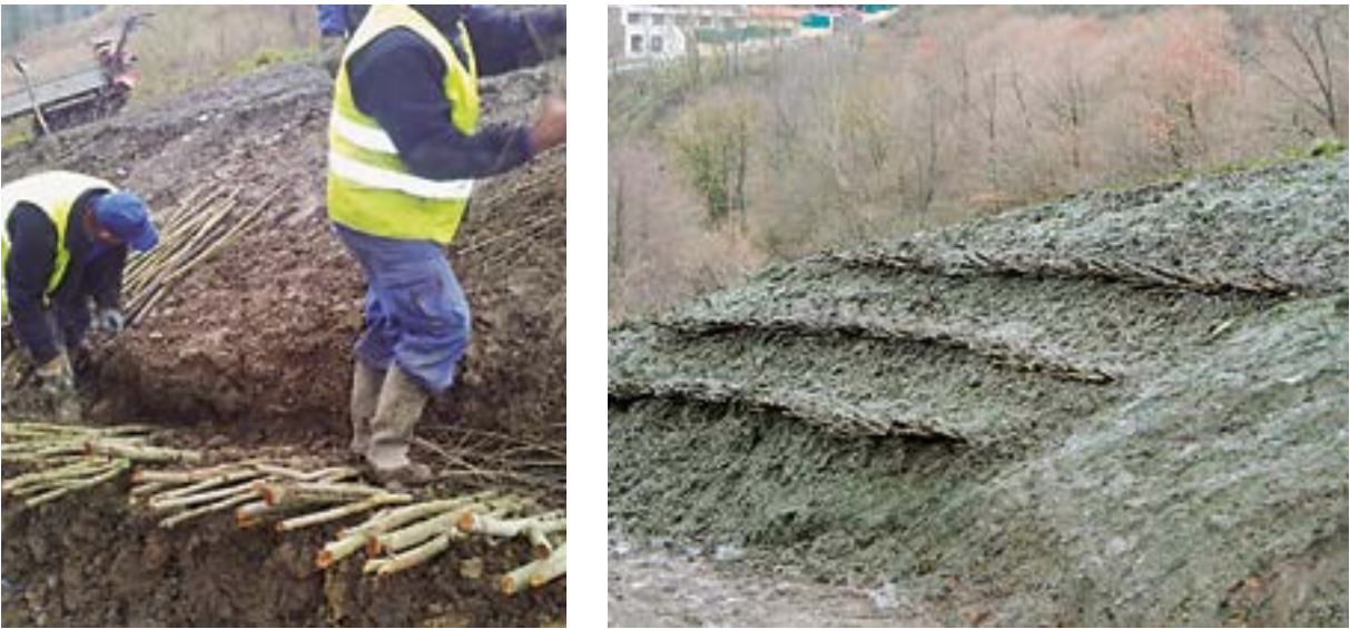
58. irudia. Adar-mailak jartzeko lanaren eskema. Iturria: P. Sangalli – SCIA SL
