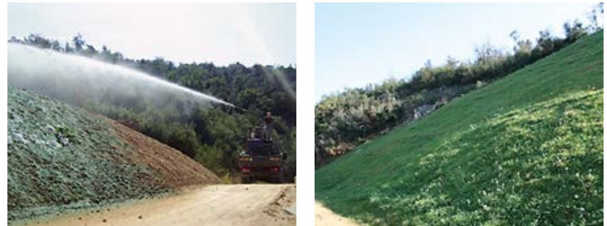
Imagen 89. Aplicación de hidromanta y tras la ejecución. Fuente: A. Sorolla
