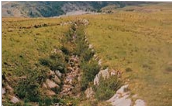
Imagen 190. Cuneta de piedra vegetada: esquema constructivo; y Merano 2000. Fuente: F. Florineth con dibujo de S. Sangalli - SCIA S.L.
