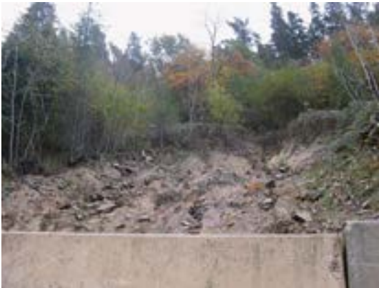
Imagen 43. Situación del deslizamiento y cuneta rota. Fuente: P. Sangalli - SCIA S.L. - IKERLUR S.L.
