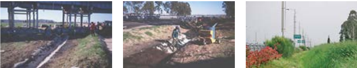
Imagen 194. Fases del proceso constructivo con la malla rellena de árido y embreada in situ
