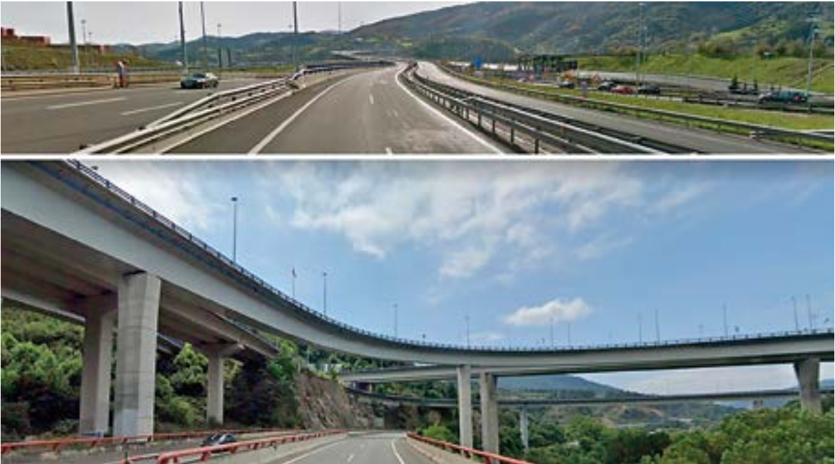
Imagen 16. Efecto barrera e impacto visual de las infraestructuras viarias
