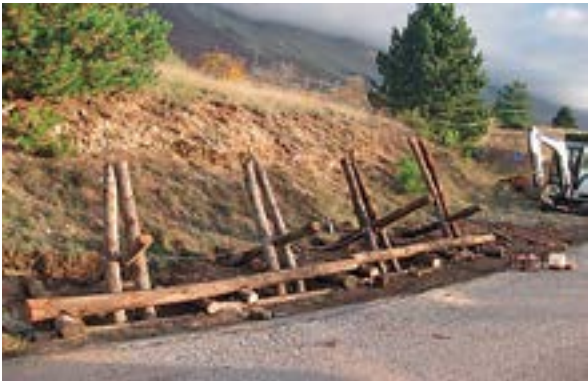
Imagen 140. Imagen Entramado Aquila en construcción. Fuente: P. Cornolini
