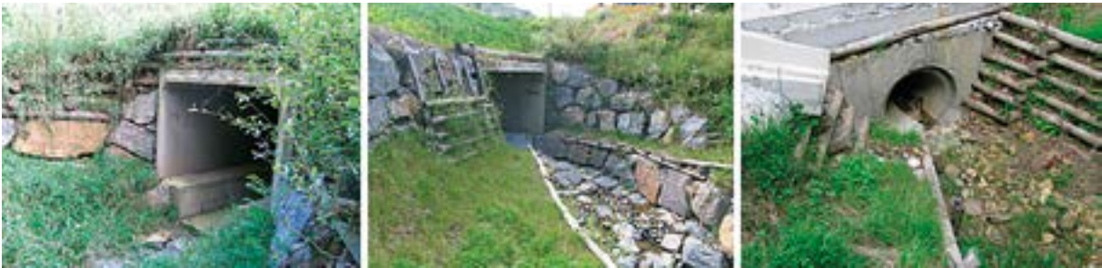
Imagen 22. Ejemplos de diferentes tipos de pasos de fauna. Carretera Arcentales, tramo Malabrigo. Fuente: DFB
