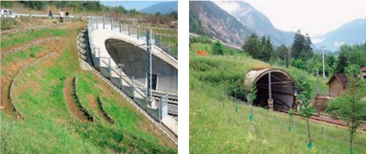
Imagen 25. Integración paisajística con técnicas de bioingeniería en túnel. Fuente: P. Cornellini
