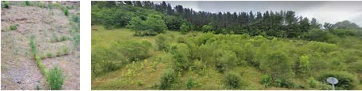
Imagen 104. Fajina de drenaje de la variante Bergara GI-627. Fuente: P. Sangalli - SCIA S.L. y A. Bea
