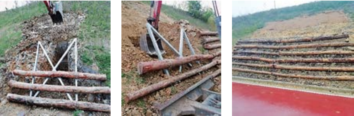
Imagen 72. Montaje de estructura loricata. Fuente: R. Etxebarria. Bidegorri Arrigorriaga. DFB
