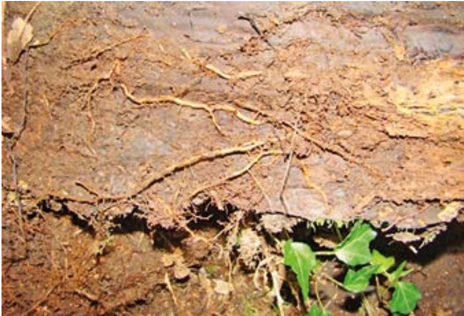
Imagen 30. Troncos de un entramado de madera en fase de descomposición muy avanzada (río Artia, Irún). Las raíces de la vegetación ocupan el espacio anteriormente utilizado por los troncos y absorben sus nutrientes. Fuente: G. Tardío.
