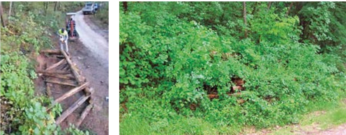
Imagen 135. Ejemplo de entramado vivo latina en ejecución y tras unos meses. Fuente: P. Cornolini
