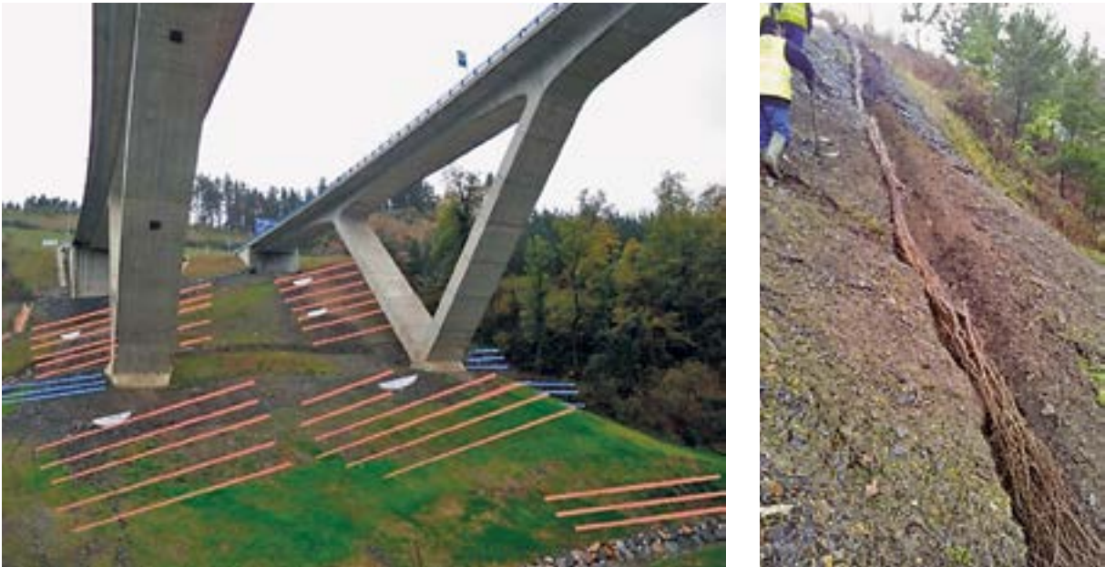
Imagen 57. Esquema de implantación de fajinas y lechos de ramaje/fajina transversal en ejecución. . Fuente: P. Sangalli - SCIA S.L.
