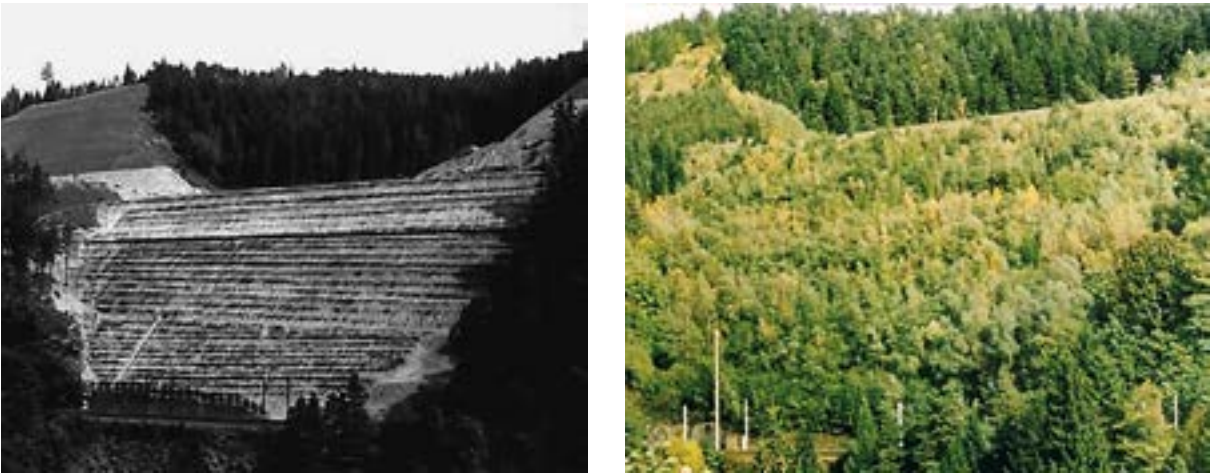
Imagen 108. Terraplén construido con lechos de ramaje. Fuente: Ugo Schiechtln. Autopista Brennero. Austria
