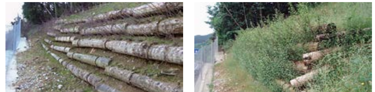
Imagen 47. Loricatas superiores recién terminada y loricatas superiores terminada. En la imagen 45 se corresponde con el punto 4. Fuente: P. Sangalli - SCIA S.L.
