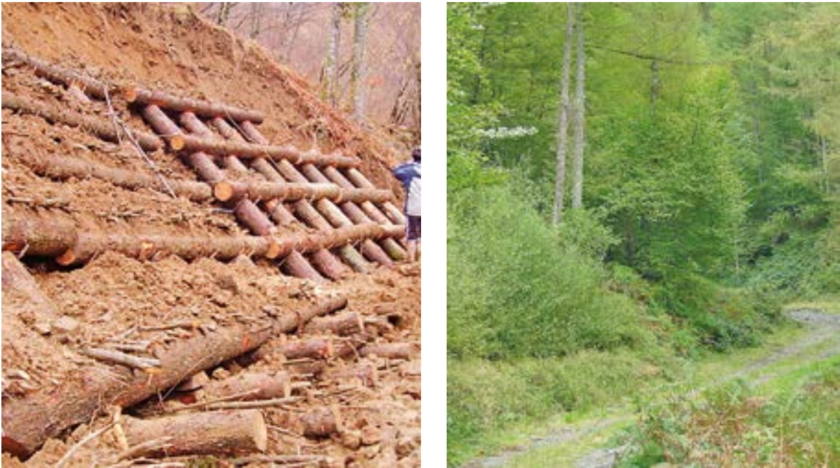
Imagen 167. Pista Leizaran durante la ejecución de las obras y la estructura desarrollada. Fuente: P. Sangalli - SCIA S.L.
